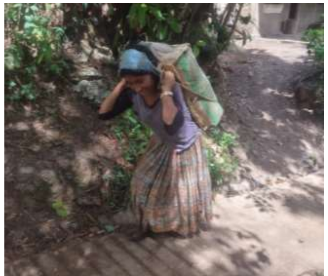
Mit grossem Einsatz beteiligen sich die Frauen aktiv an den Arbeiten für die neue Wasserversorgung in Chimolon!
