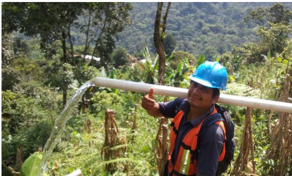
Überlauf des Restwassers und Bachquerung mit aufgehängter Leitung
