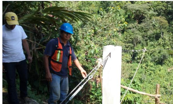
Überlauf des Restwassers und Bachquerung mit aufgehängter Leitung
