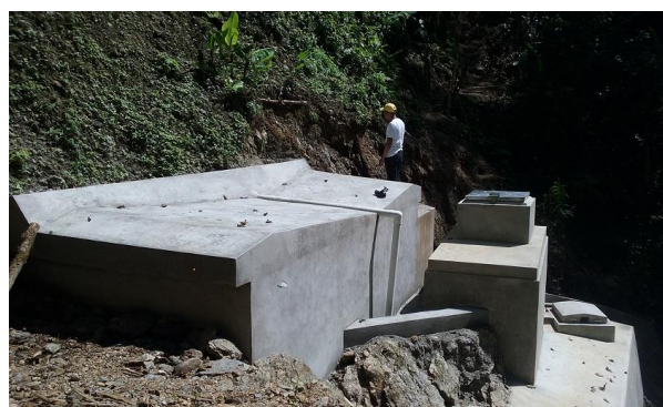
Die Quelle im ursprünglichen Zustand und die Quelfassung im Bau
